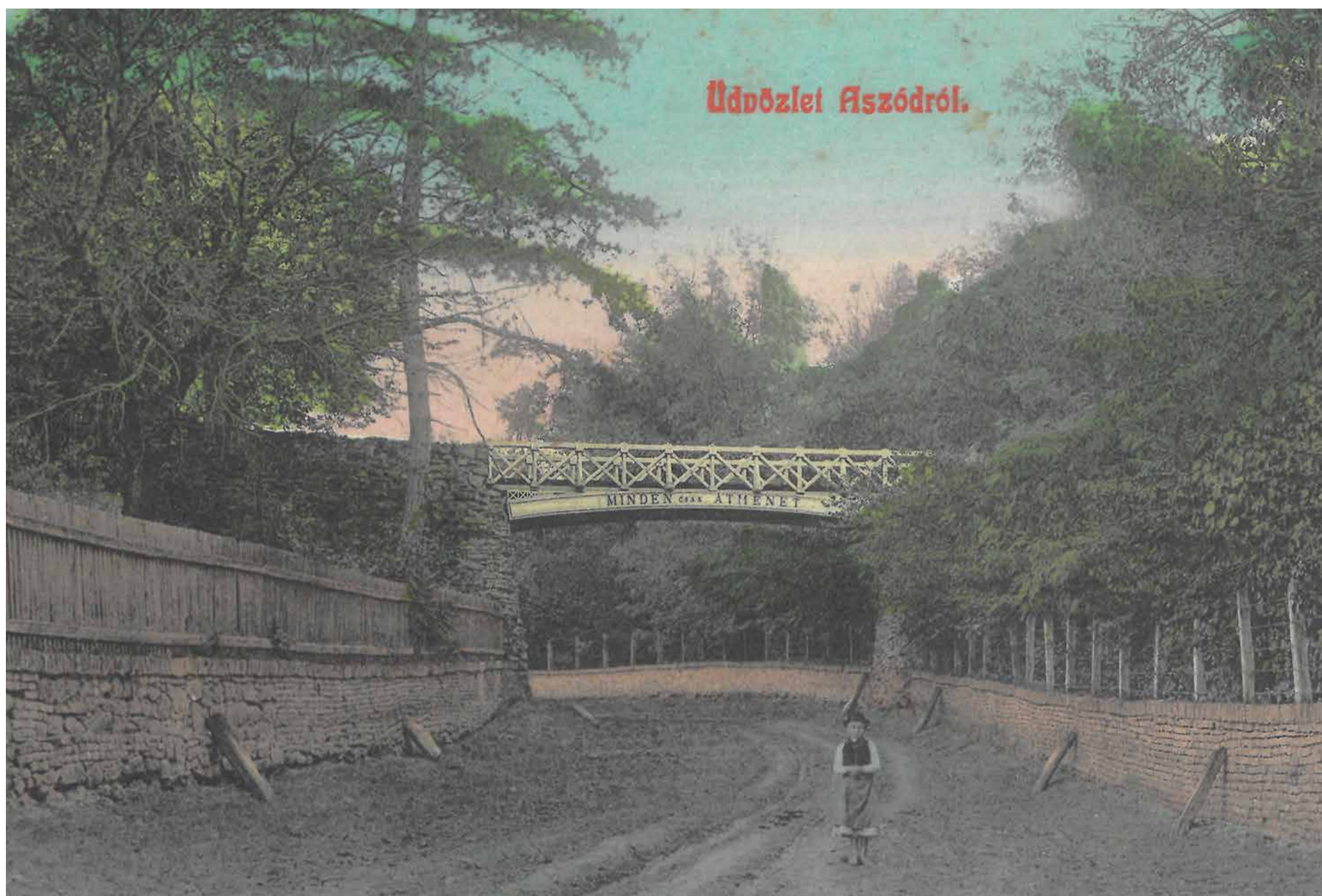
A Mély út felett átívelő híd | The bridge over Mély street | Brücke über der Mély-Straße
