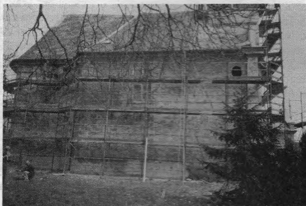
Megkezdődött a helyreállítás
