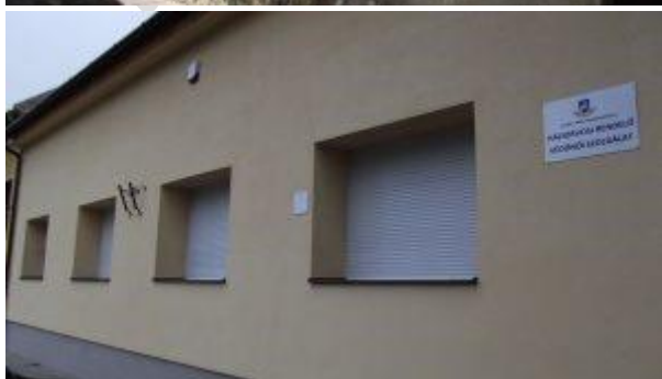
Az épület a felújítás után
